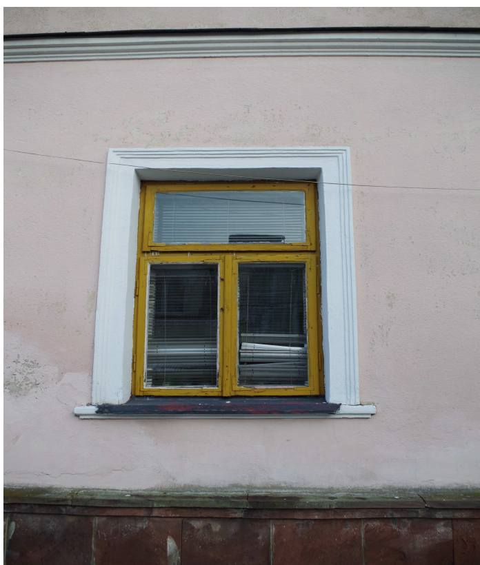
Fot. Nr 7 Okna w elewacji południowej i zachodniej do wymiany
