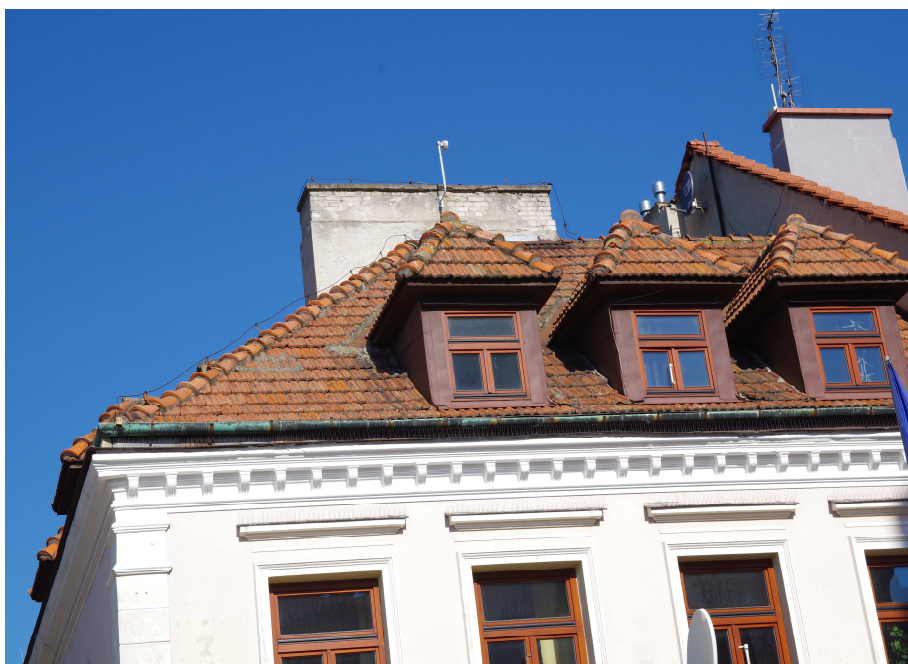
Fot. Nr 2 Pokrycie dachu dachówka ceramiczna „Marsylką „ w kolorze naturalnym i fragment komina
