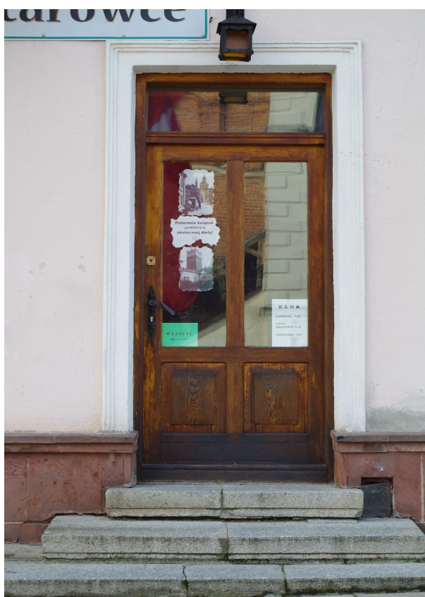
Fot. Nr 9 Drzwi w elewacji wschodniej do wymiany lub renowacji oraz schody do przebudowy
