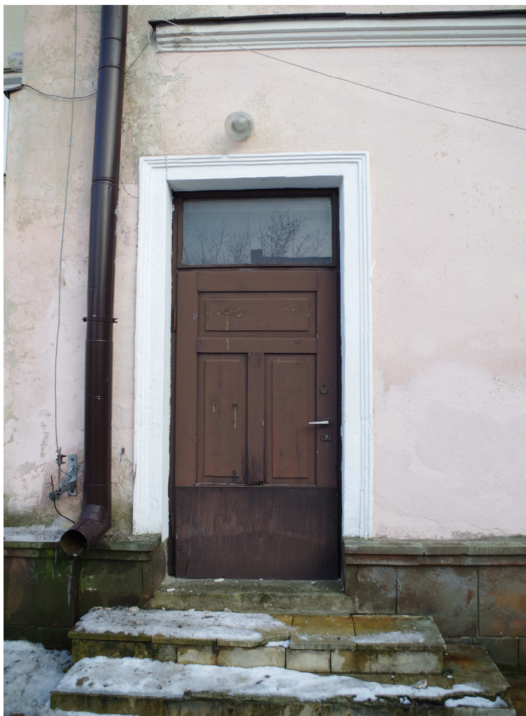
Fot. Nr 10 Drzwi w elewacji zachodniej do wymiany i schody do przebudowy
